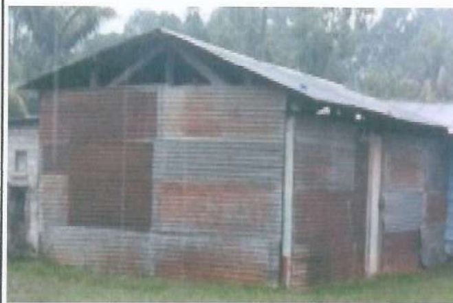
Foto 2: MEJORAMIENTO DE TECHO
