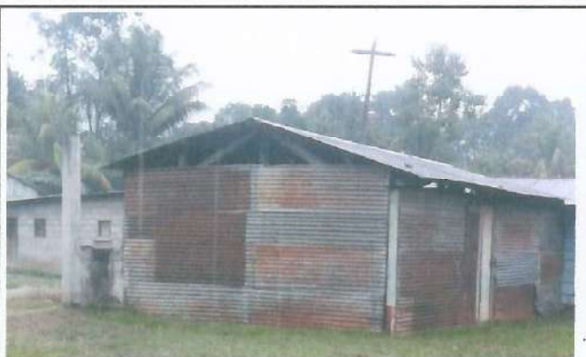
Foto 3: MEJORAMIENTO DE PISO
