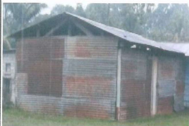
Foto 1: MEJORAMIENTO DE PAREDES
