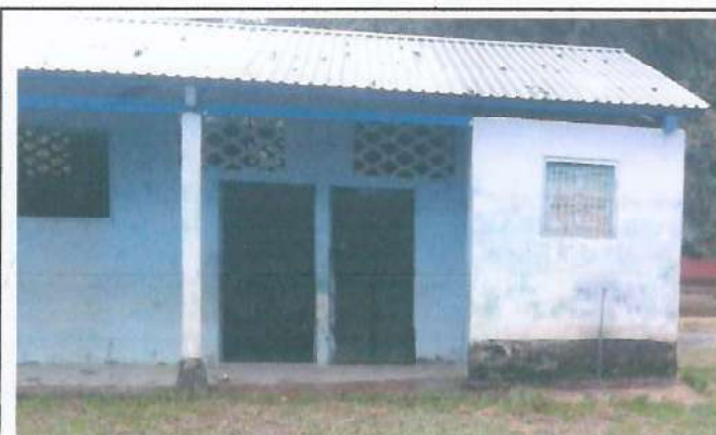
Foto 4: MEJORAMIENTO DE TECHO Y PISO, AULA 2
